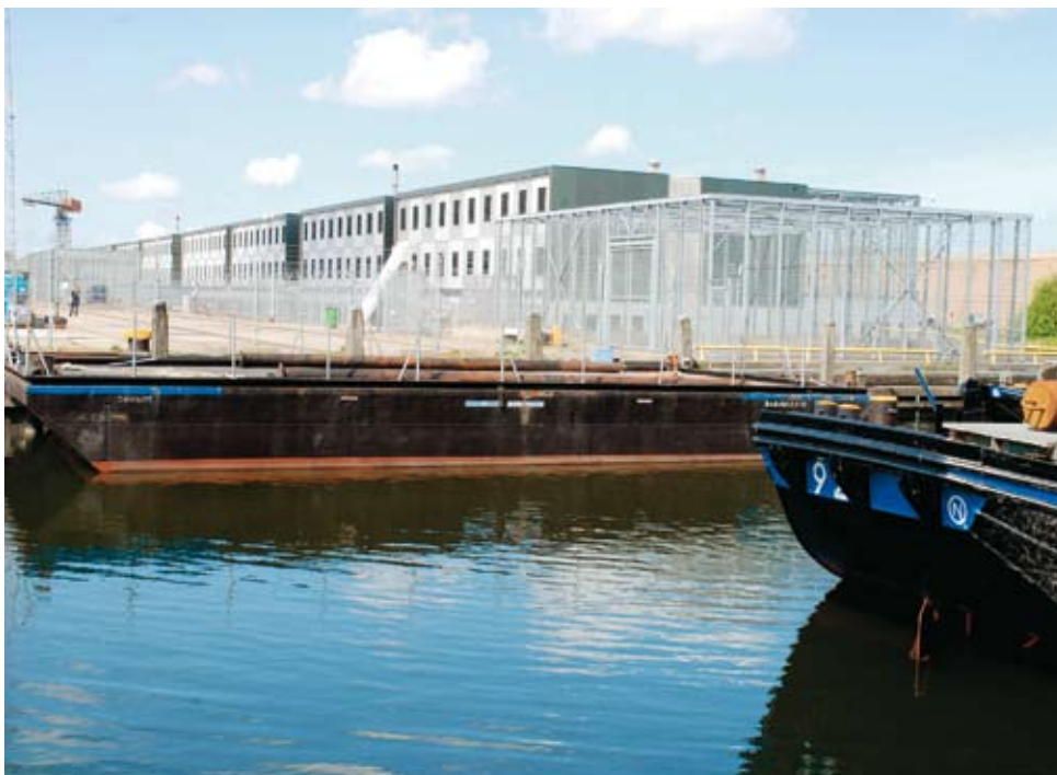
Onder: Detentiecentrum (boot) Zaandam
